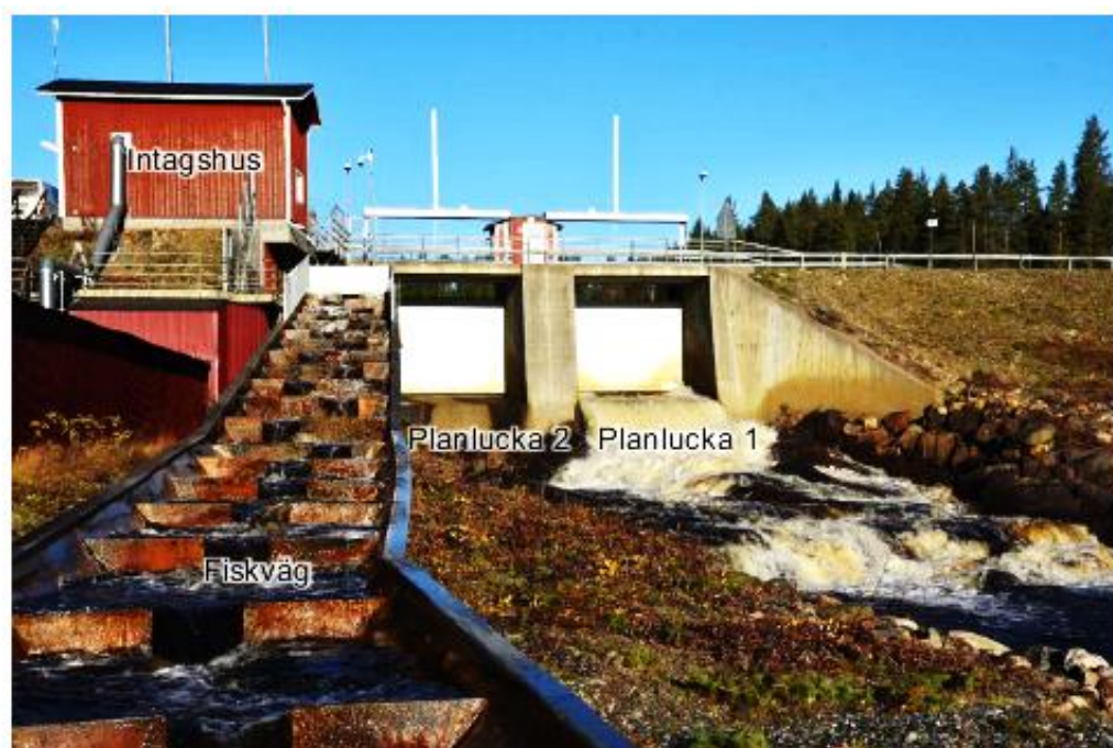
Figur 1 Nedströmsvy över Hednäs regleringsdamm.
