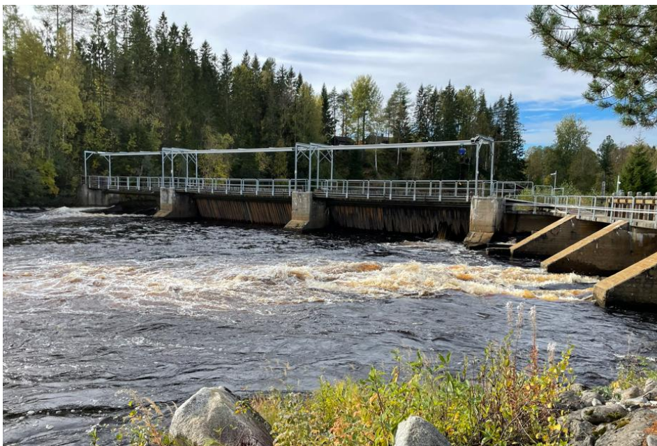
Figur 5: Nedströms vy över Agnäs regleringsdamm
