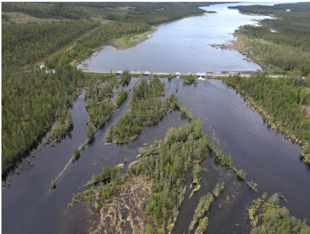
Figur 5. Flygbild mot dammen från nedströmssidan. Bortom dammen syns sjön Malmesjaure, i förgrunden Lobblet som är en del av Abmoälven.
