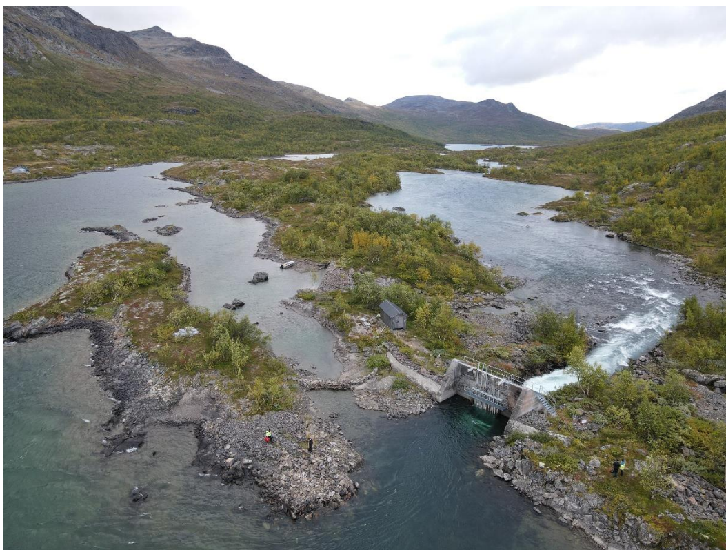
Figur 15. Drönbild som bland annat visar utskovsdammen. Längs till vänster i bild syns Skellefteå krafts stuga, som används av bolagets personal vid drift och tillsyn av anläggningen.
