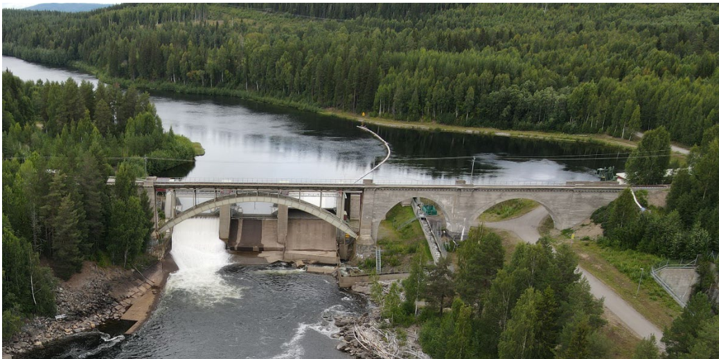
Figur 20. Foto som visar järnvägsbron över Piteälven vid Sikfors. Bakom järnvägsbron finns dammen och under det längsta brospannet syns delvis tre av utskoven i dammen.
