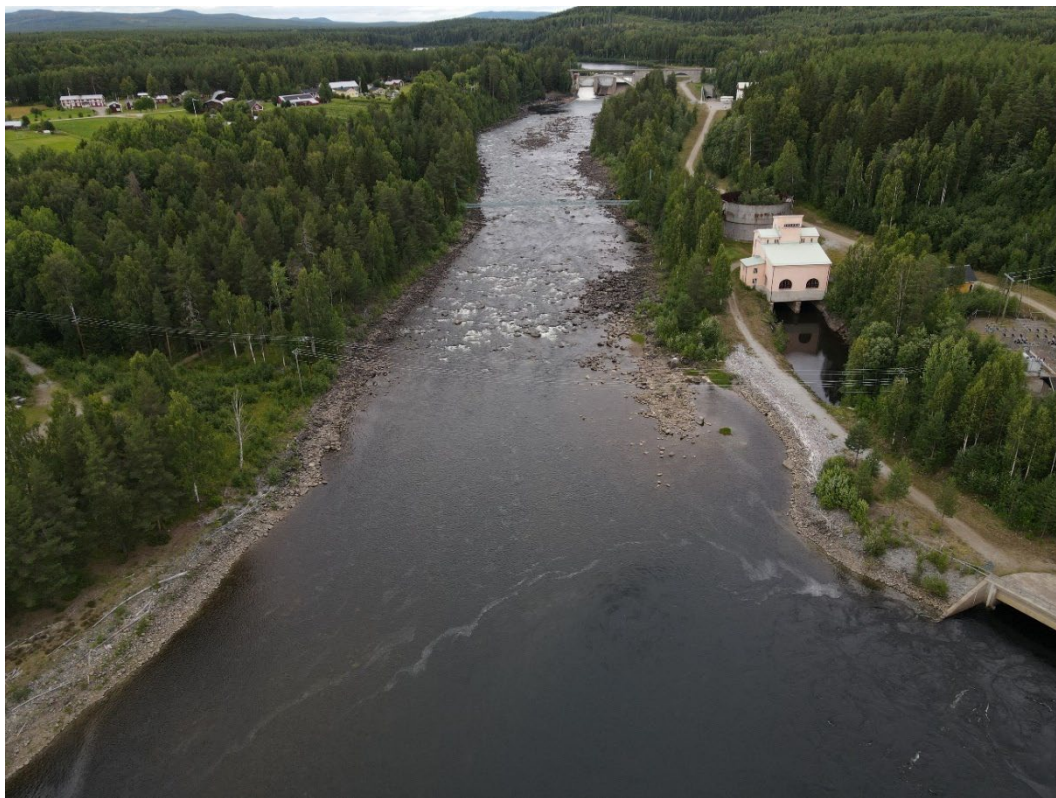
Figur 11. Flygbild som visar spillfåran vid Sikfors vid en spilltappning om ca 15 m 3 /s.
