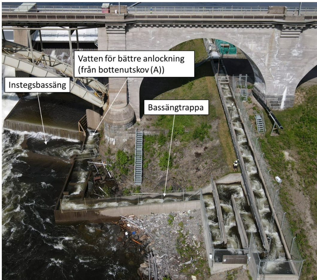
Figur 6. Flygfoto som visar delar av fiskvägen för uppströmsvandring med instegsbassäng, vatten från utskov A och bassängtrappan.
