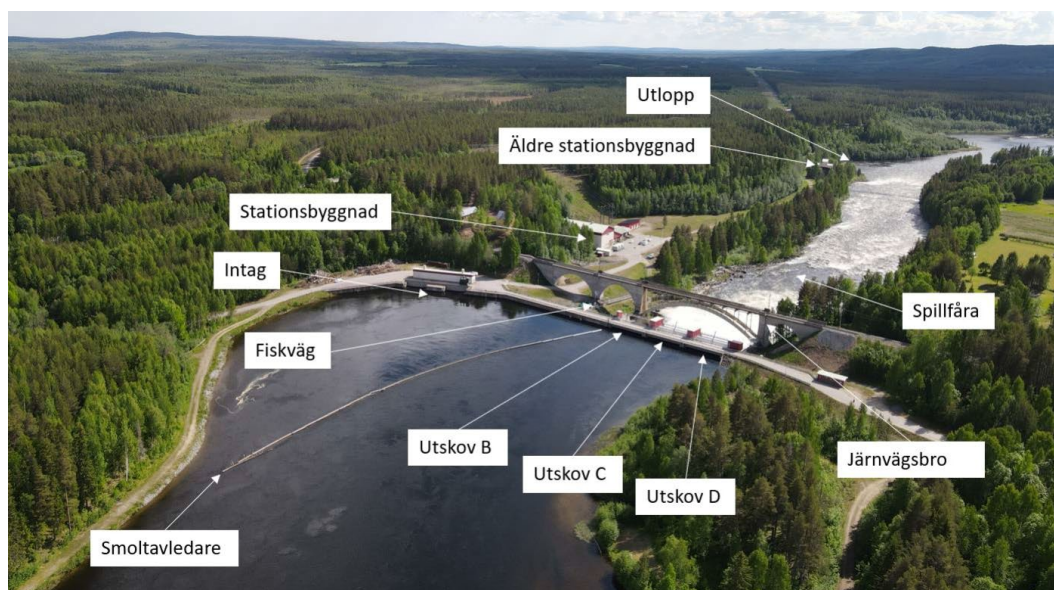
Figur 5. Flygbild med markeringar för vissa anläggningsdelar vid Sikfors kraftverk.
