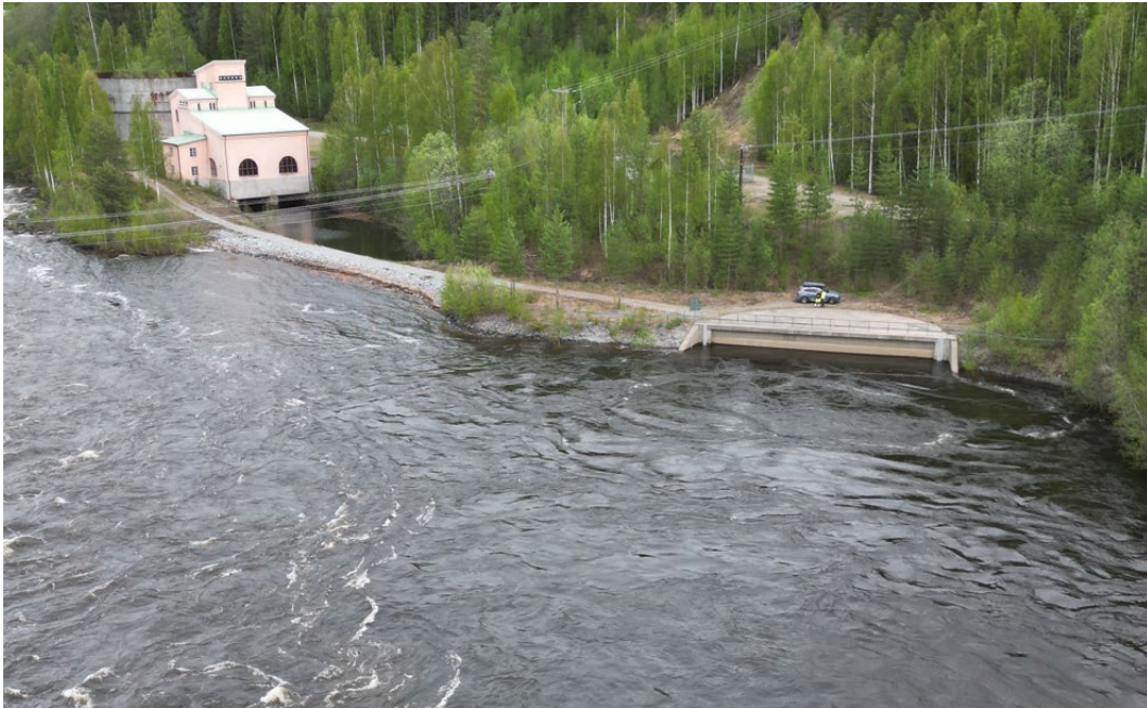
Figur 19. Foto som till vänster i bild visar den gamla kraftstationen. Bakom byggnaden syns del av svalltornet. Till höger i bild det nuvarande tunnelutloppet.
