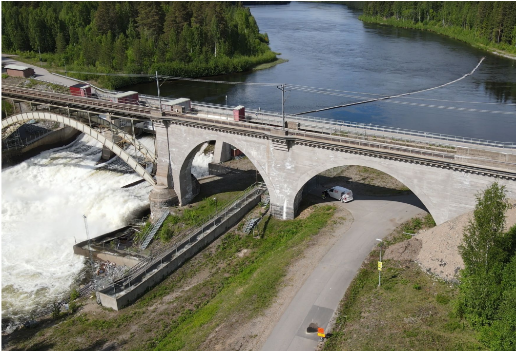
Figur 10. Flygbild där smoltavledaren syns i älven på dammens uppströmssida.
