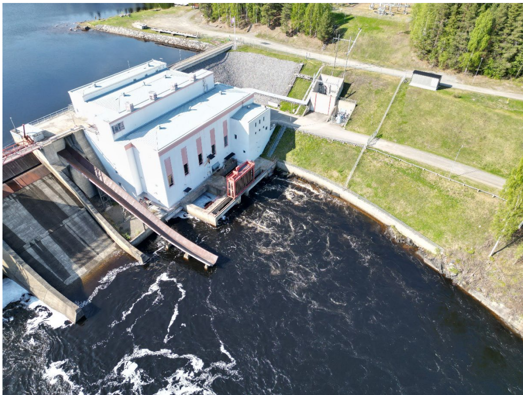
Figur 4. Granfors vattenkraftverk från nedströmssidan. Det nya aggregatet G3 planeras till vänster om den befintliga kraftstationsbyggnaden, i läget för flottningsrännan och del av utskovet.
