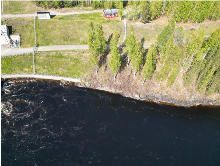
Figur 34. Del av arbetsområdet på vänstra stranden, med befintlig kontorsbyggnad centralt i bildens övre del.
