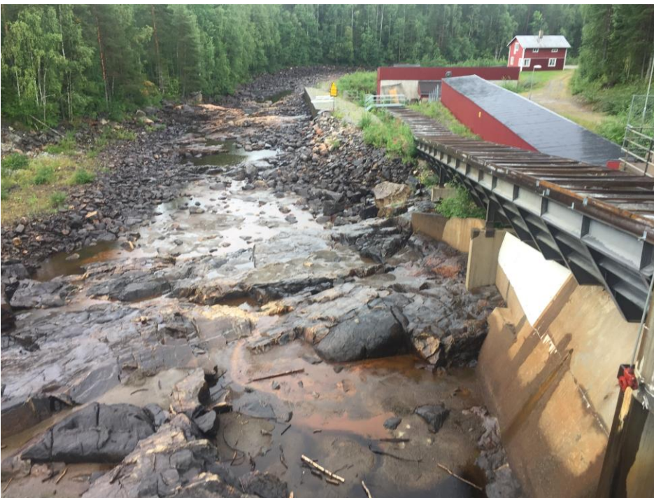
Figur 22: Spillfåra nedströms kraftverket
