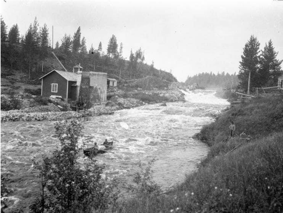
Figur 9: Storfallet i Åbyälven innan uppförandet av Hednäs kraftstation. Sågen från 1895 syns t.v. i bild. Foto: okänd. Bild ur Länsstyrelsens nulägesbeskrivning.
