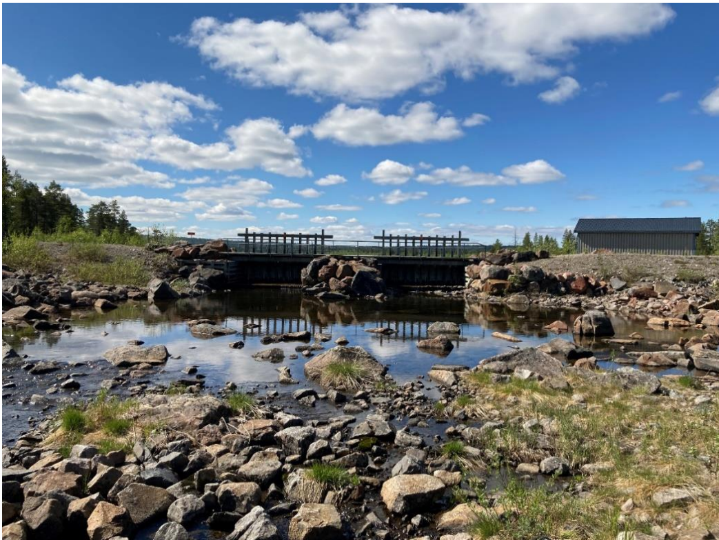
Figur 5-12. Foto taget från nedströmssidan. Längst till vänster i bild dammdel I följt av dammdel H med utskov 4 och 3, därefter längst till höger dammdel G.
