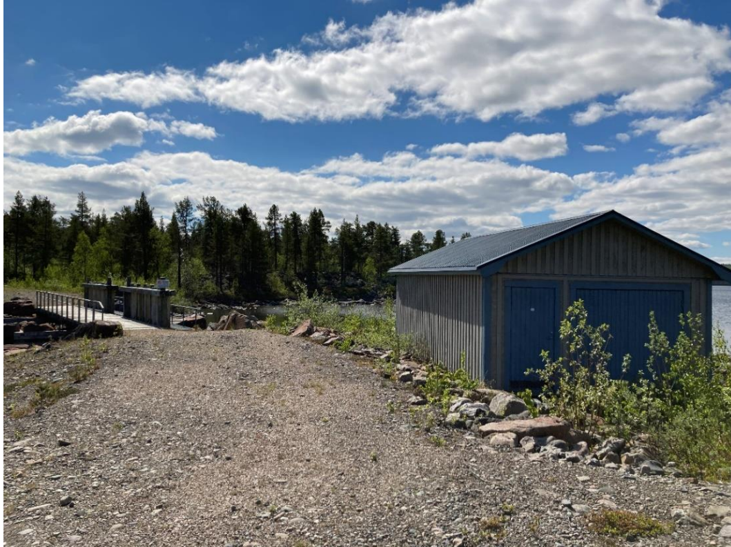
Figur 5-10. Foto i vars förgrund del av dammdel G syns. I bakgrunden syns damm H och I samt utskov 3 och 4. Byggnaden till höger är ett båthus.
