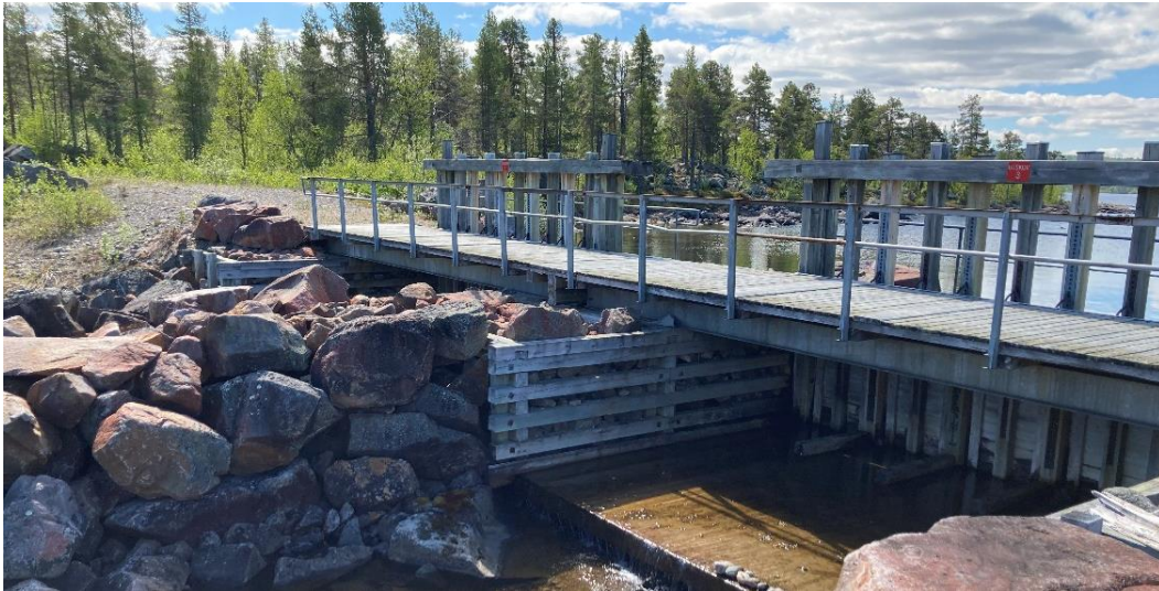
Figur 5-11. Foto som visar dammdel H, utskov 4 och del av brobanan.
