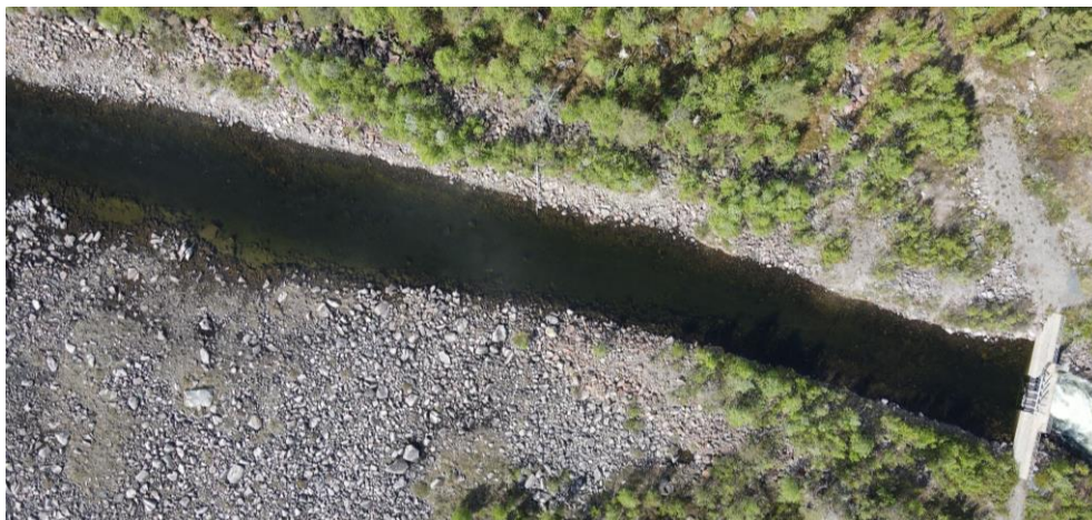
Figur 5-14. Drönbild som visar del av sänkningskanalens uppströmsdel. Till höger i bild dammdelar och utskov 1.
