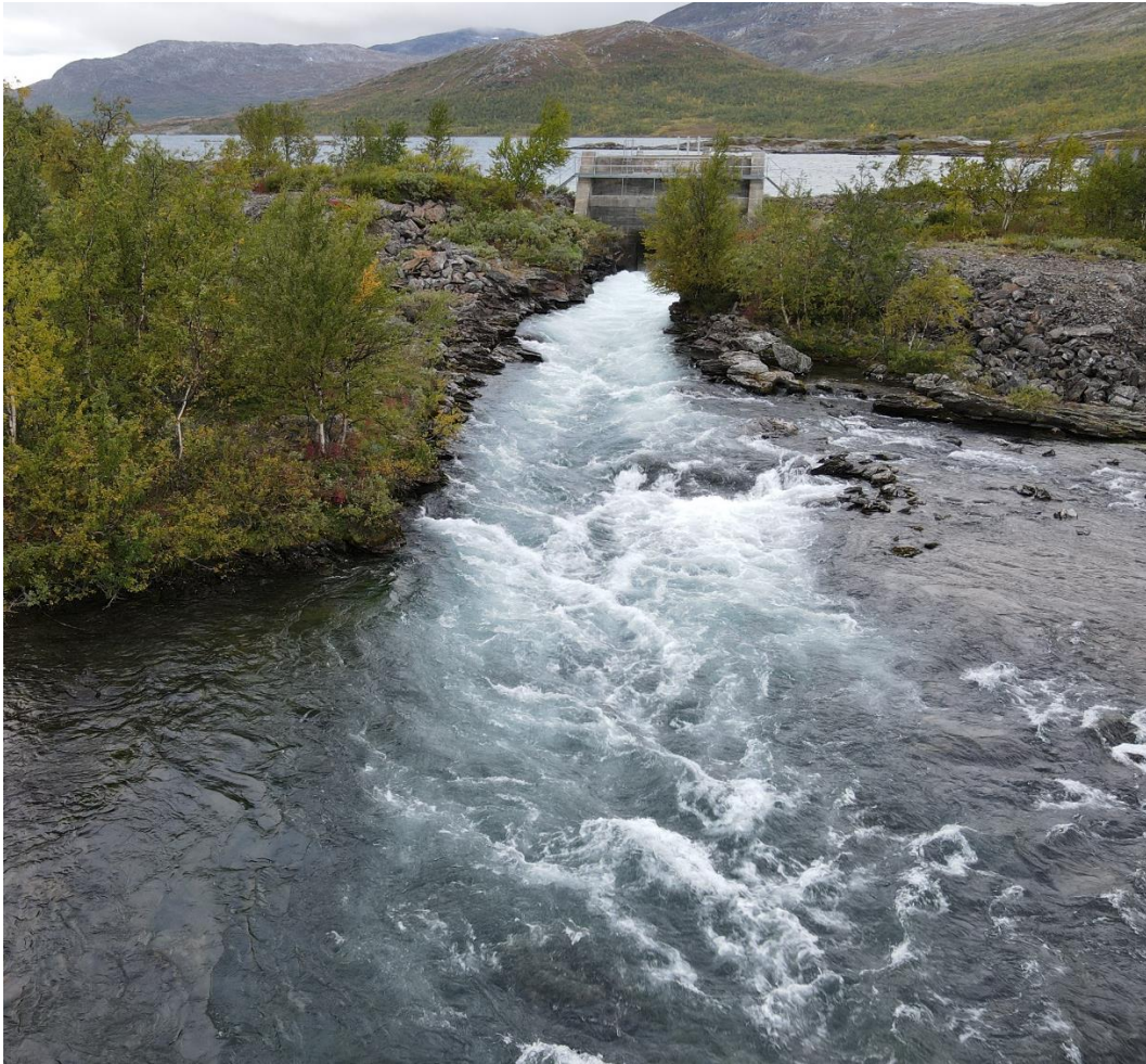
Figur 5-9. Sänkingskanalen från nedströmssidan.
