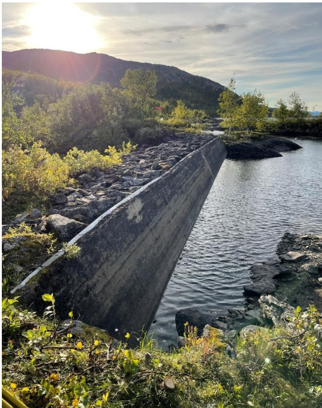
Figur 5-6. Spärrdamm (Damm A).
