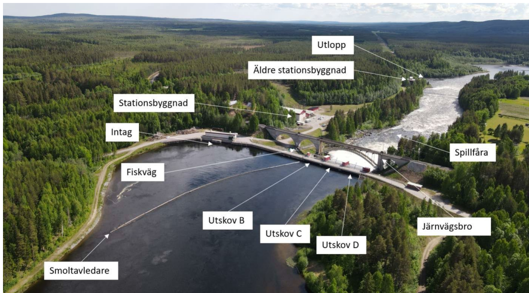
Figur 6-2. Flygbild från anläggningens uppströmssida med markeringar för anläggningsdelar.
