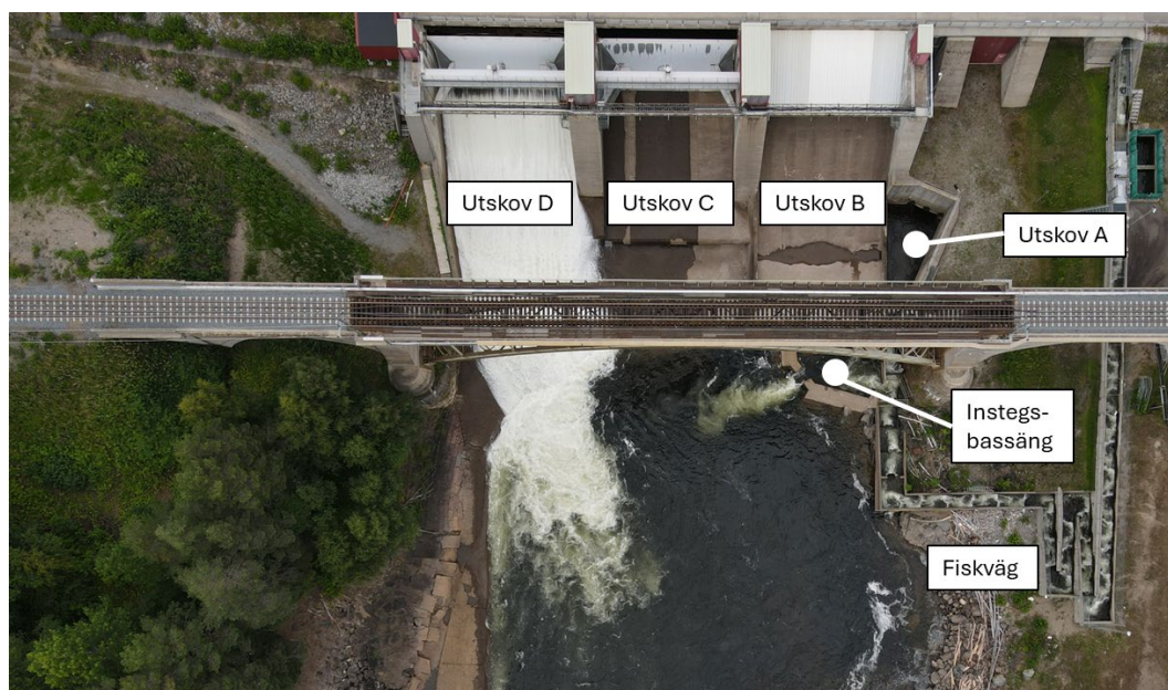
Figur 6-4. Flygbild från nedströmssidan. Bilden visar samma anläggningsdelar som Figur 6, men vid andra (lugnare) flödesförhållanden. Vid fototillfället (augusti 2022) spilldes ca 1 m 3 /s från fiskvägen, ca 2 m 3 /s från utskov A och ca 12 m 3 /s från utskov D. Detta är ett exempel på ett vanligt förekommande driftförhållande under sensommaren och hösten.
