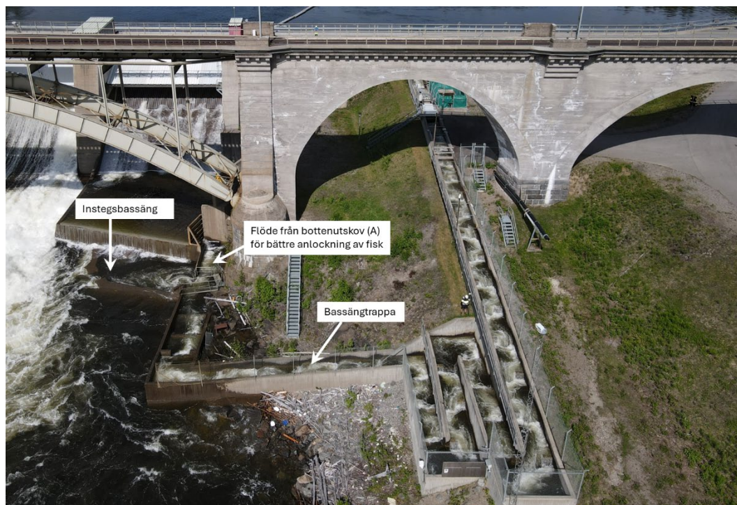
Figur 6-5. Befintlig fiskväg. Flygfoto från nedströmssidan.
