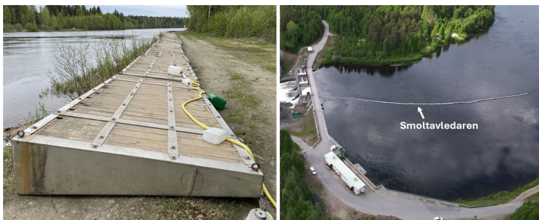
Figur 6-6. Smoltavledaren. Till vänster: Avledaren urdrifftagen på land, där de enskilda flytelementens utformning framgår på bilden. Till höger: Smoltavledaren i drift.
