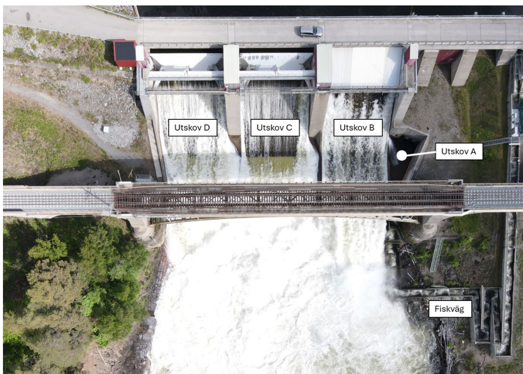
Figur 6-3. Flygbild från nedströmssidan. Utskov A är ett bottenutskov. På bilden framgår den befintliga fiskvägens läge. Observera att bilden är tagen vid en flödessituation och att fiskvägens instegsbassäng överströmmas av vatten från utskov B.
