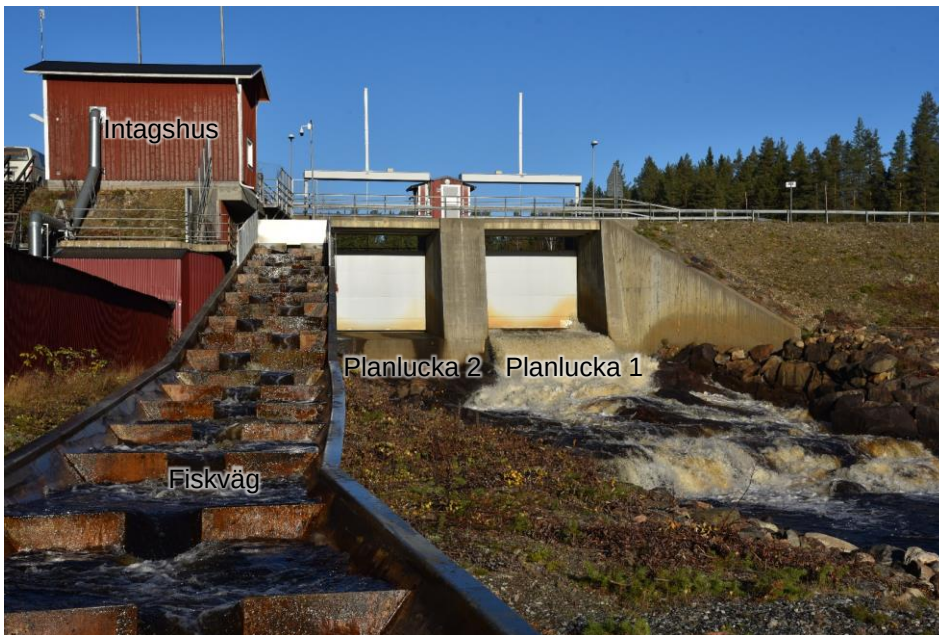
Figur 5. Nedströmsvy över Hednäs regleringsdamm.
