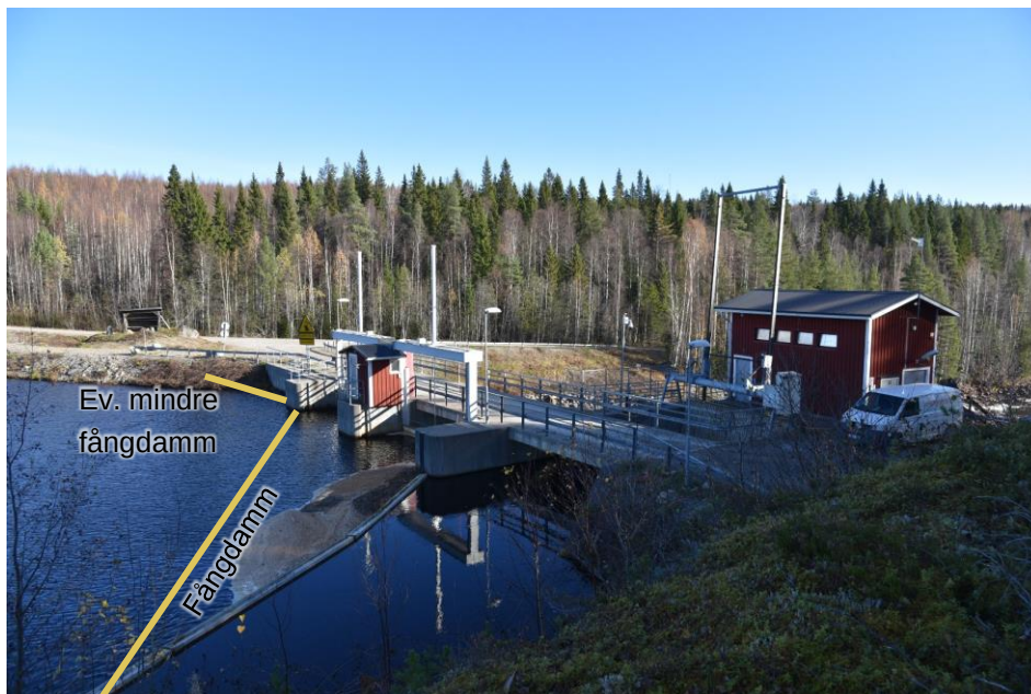
Figur 19. Hednäs regleringsdamm. Förslag till planerad utrivning av betongkonstruktioner. Enligt planen är vattennivån redan sänkt ca 3 m och fyllningsdammen längst bort i bild är nedschaktad.
