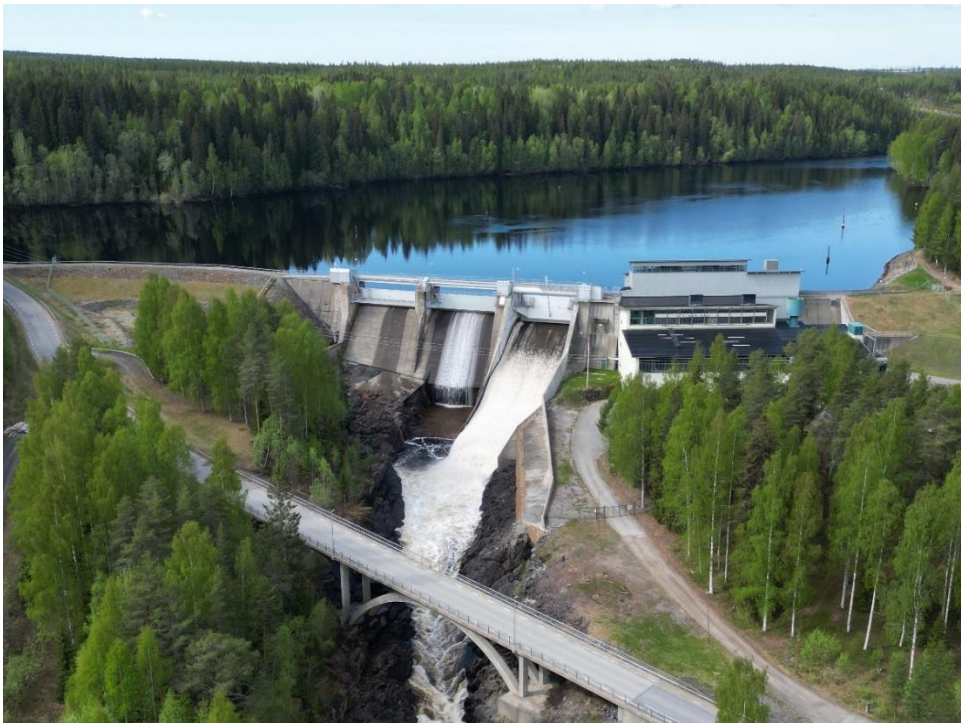
Figur 3. Krångfors vattenkraftverk från nedströmssidan.
