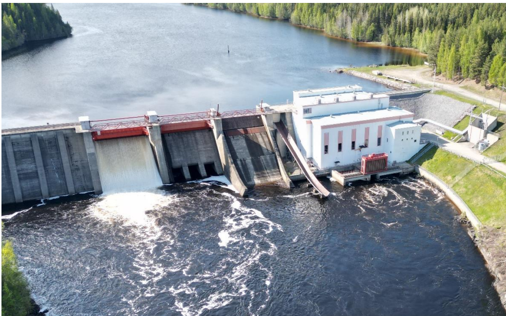
Figur 3. Granfors vattenkraftverk från nedströmssidan.
