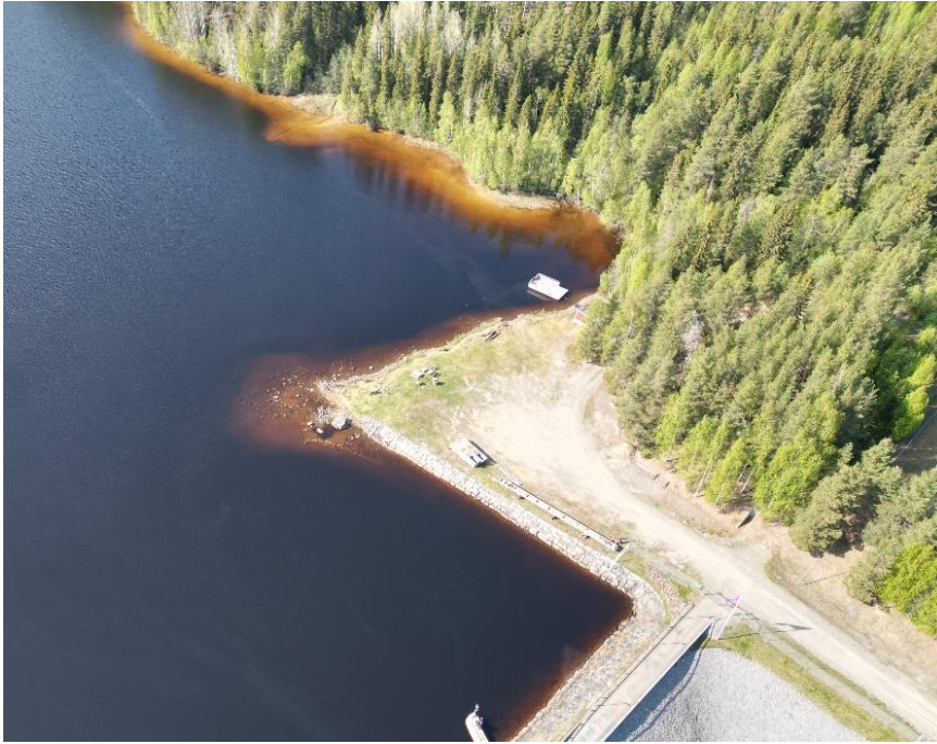
Figur 5. Platsen för den nya kraftstationsbyggnaden. I dagsläget finns en öppen gräs-/grusyta och en mindre brygga på platsen. Delar av den befintliga dammanläggningen kan ses nederst i bilden.
