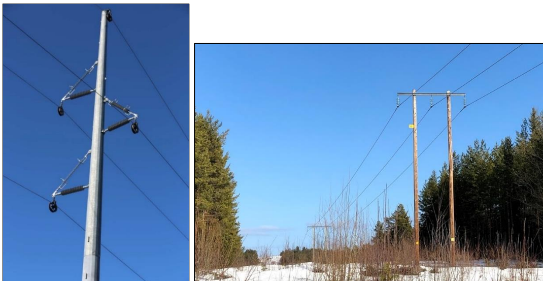
Figur 2-1. Exempel på planerade stolpkonstruktioner. Exemplet till vänster visar vertikal stålörsstolpe och exemplet till höger visar portalstolpe i trä.
