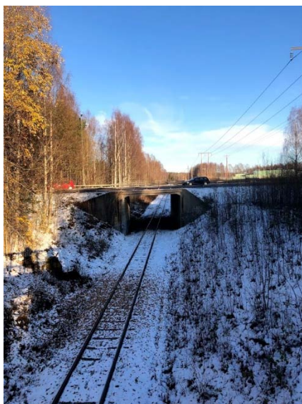
Figur 2 - Banvallen där ledningsförläggningen planeras. Befintlig 30 kV ledning syns till höger i bilden.
