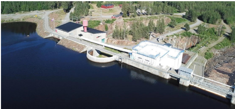
Figur 2. Selsfors kraftverk uppströmsvy. Mellan stationsbyggnaderna syns en valvdamm som anlades vid uppförandet av dammen, i syfte att underlätta en eventuell framtida utbyggnad med ytterligare ett aggregat.
