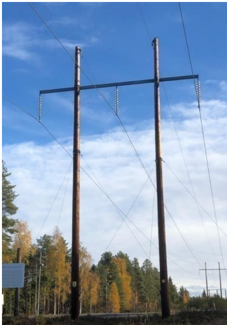
Figur 4-1. Exemplet visar en portalstolpe i trä med två topplinor.
