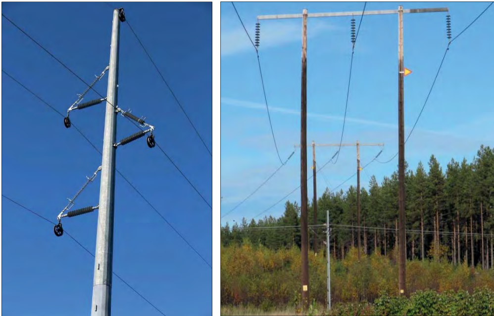
Figur 3. Principskiss av planerad stolpkonstruktion. Exemplet till vänster visar gitterstolpe i stålörnsstolpe och exemplet till höger visar portalstolpe i trä.
