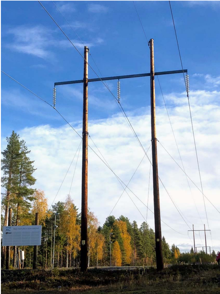
Figur 3-1. Exempel på en 170 kV-luftledning med topplina
