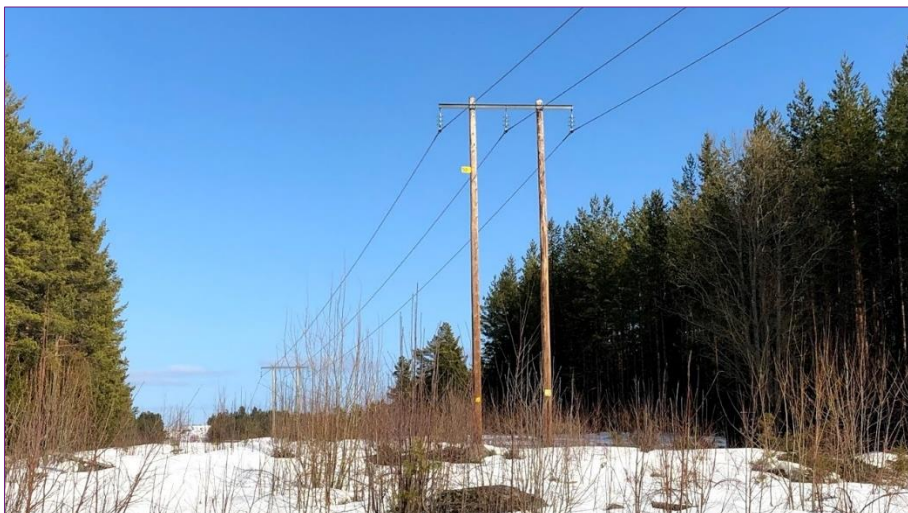
Figur 3-1. Exempel på en 36 kV-luftledning.
