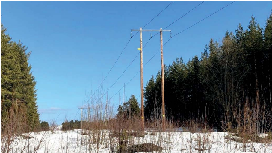
Figur 3-1. Exempel på en 36 kV-luftledning (foto Erik Spinnel).
