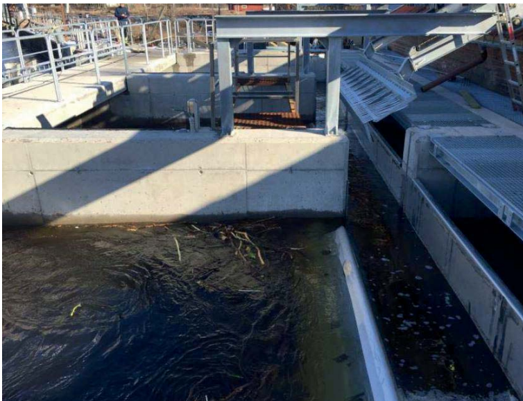
Figur 10. Exempel på ränna bakom grind från Västerkvarns kriv i Kolbäcksån i vilken skräp och avledd fisk hamnar.
