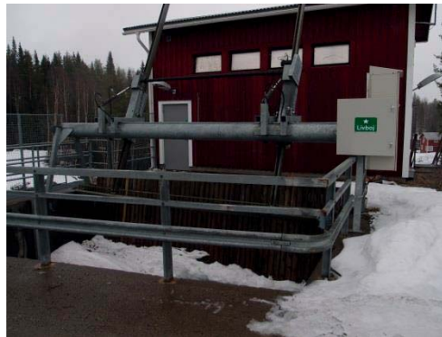
Figur 4. Hednäs kraftverk, vy mot kraftverksintaget.
