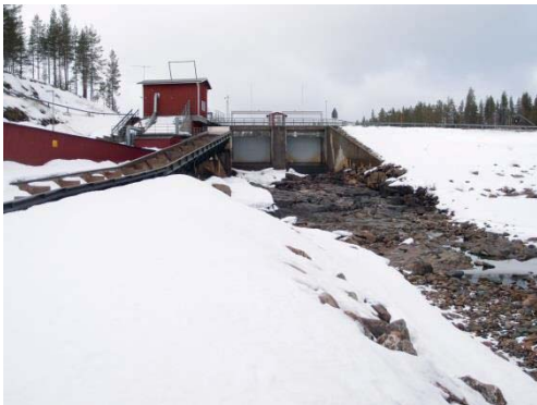
Figur 3. Hednäs kraftverk, vy mot utskovsdammen.
