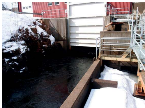
Figur 5. Hednäs kraftverk, fisktrappa och kraftverkets utlopp.
