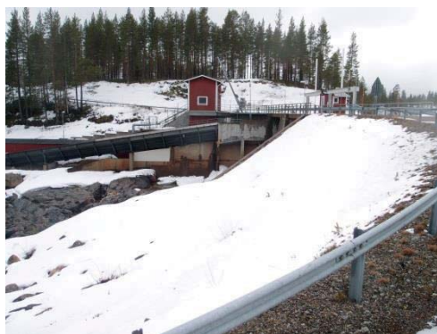
Figur 6. Hednäs kraftverk, vy utskovsdamm och intag.
