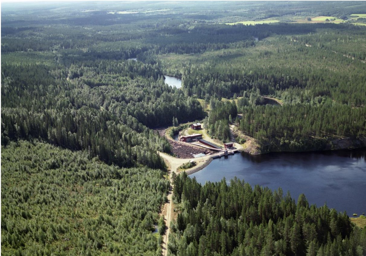
Figur 14. Flygfoto över Hednäs kraftverk med omgivning.
