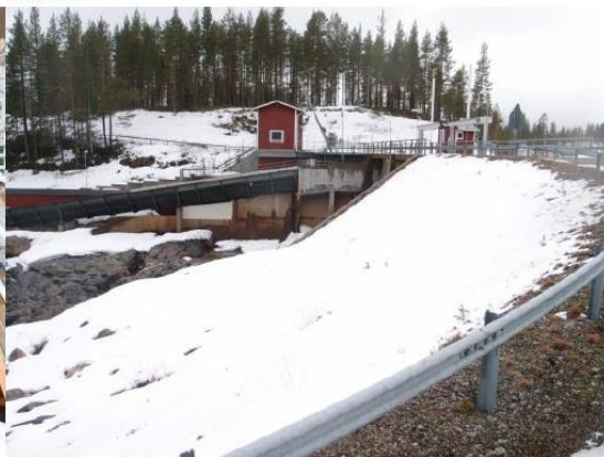
Figur 6. Hednäs kraftverk vy utskovsdamm och intag.
