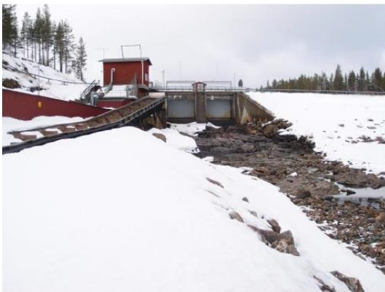
Figur 3. Hednäs kraftverk vy mot utskovsdammen.
