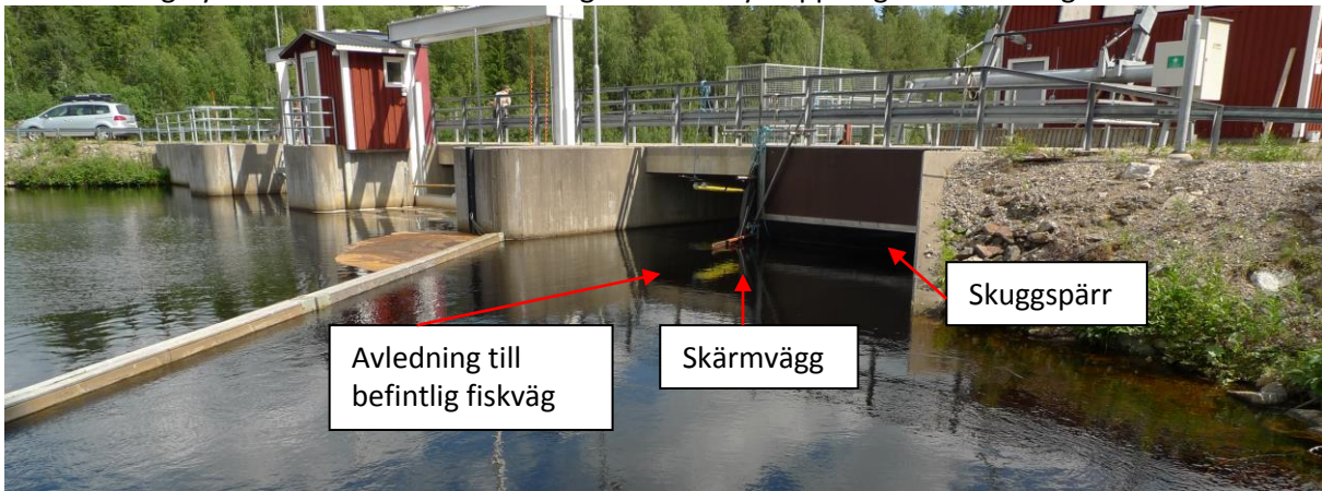
Figur 5. Foto över skärmvägg och skuggspärr i intaget till Hednäs kraftverk.
