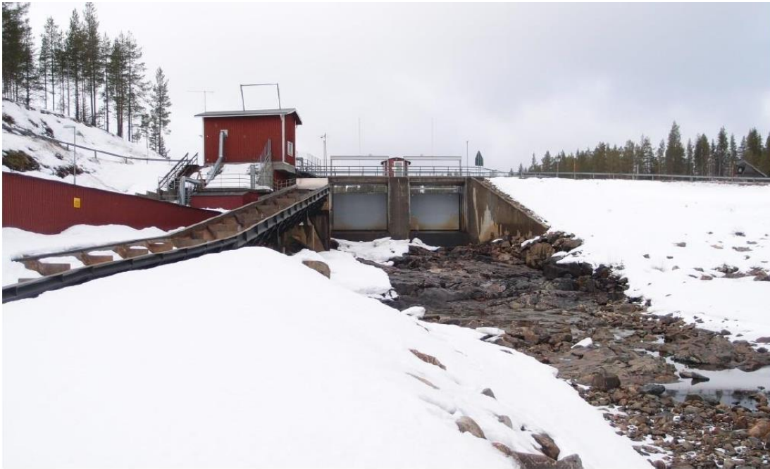
Figur 2. Hednäs kraftverk. Norconsult 2015.
