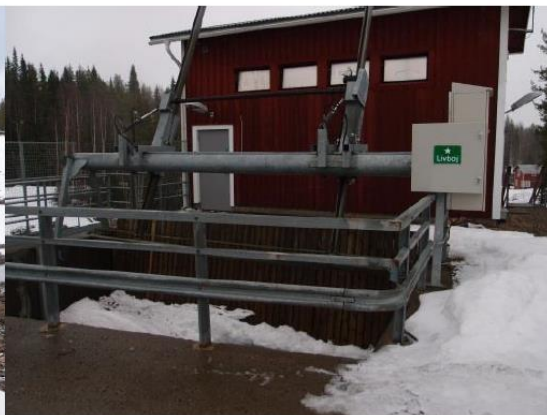
Figur 4. Hednäs kraftverk vy mot kraftverksintaget.
