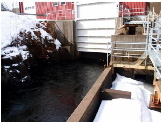
Figur 5. Hednäs kraftverk fisktrappa och kraftverkets utlopp.
