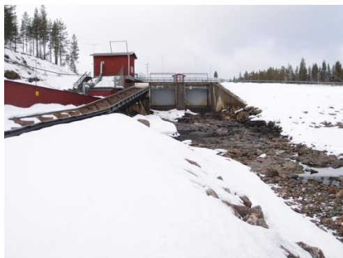
Figur 3. Hednäs kraftverk vy mot utskovsdammen.
