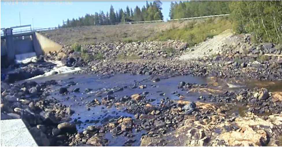
Figur 8. Då vatten spills i spillfåran riskerar uppvandrande fisk att lockas upp i spillfåran. När spillet upphör riskerar fisken att fastna och bli kvar i de vattensamlingar som bildas.
