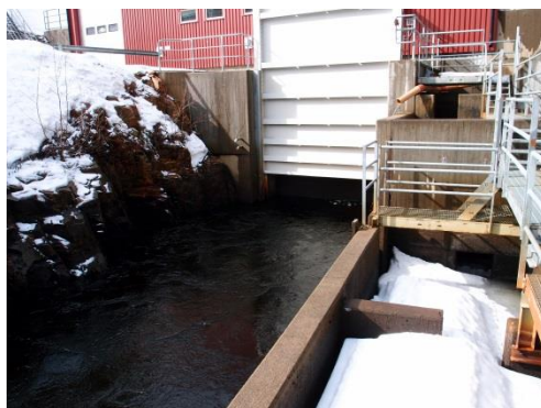
Figur 5. Hednäs kraftverk fisktrappa och kraftverkets utlopp.
