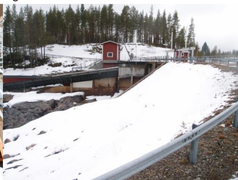
Figur 6. Hednäs kraftverk vy utskovsdamm och intag.
