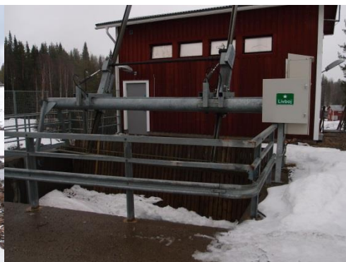
Figur 4. Hednäs kraftverk vy mot kraftverksintaget.
