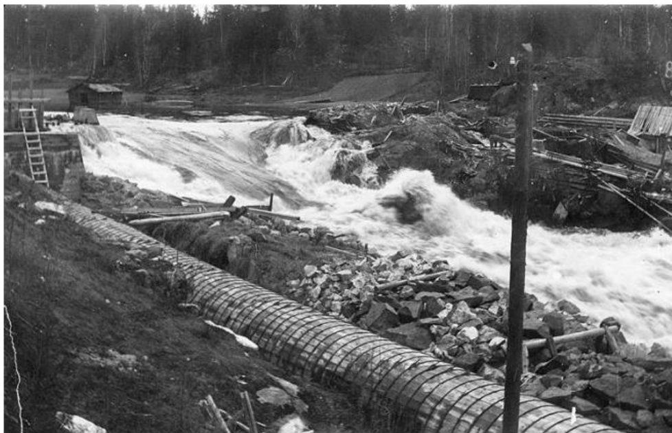
Figur 7. Foto från år 1920 då det första kraftverket uppfördes vid Hednäs visar att Storfallet var en brant fors men förefaller inte utgjorts av ett tvärt fall. Lägg märke hur delar av dammbyggnaden koncentrerar flödet med resultatet att vattenhastigheten ökar och förutsättningar för uppvandrande fisk försämras.
