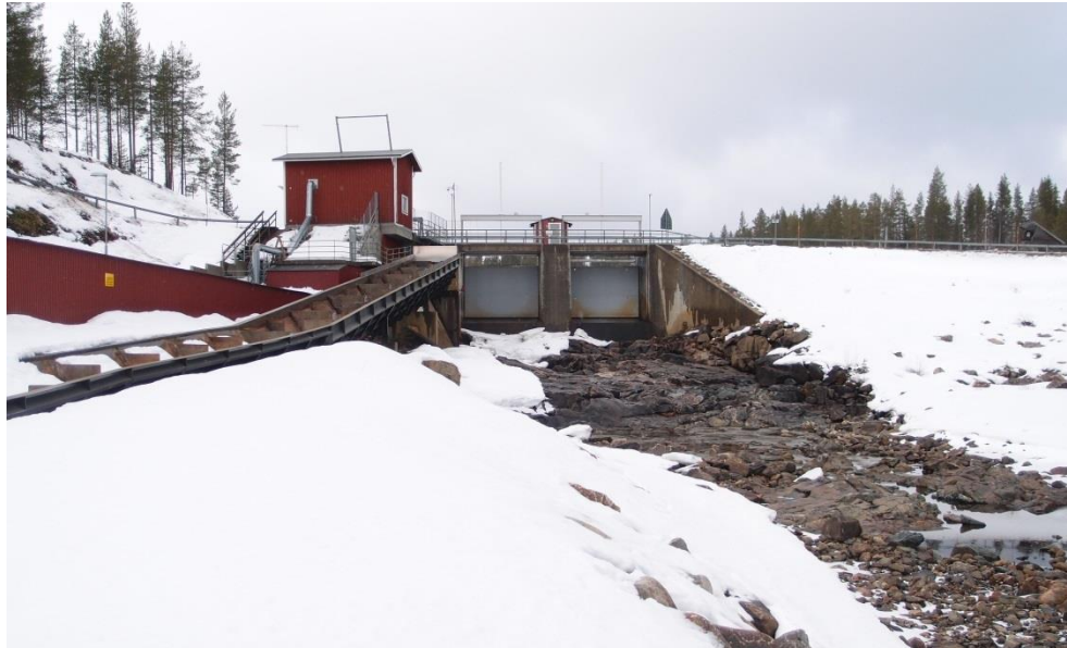
Figur 2. Hednäs kraftverk. Norconsult 2015.
