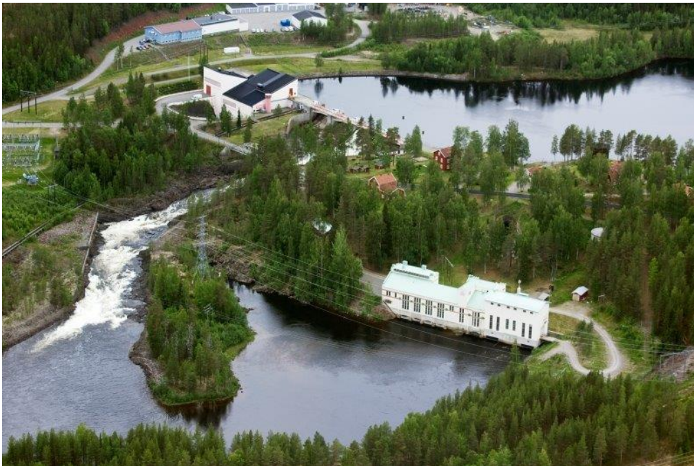
Finnfors kraftstation i Skellefteälven.
