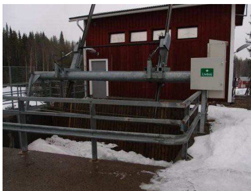
Figur 4. Hednäs kraftverk vy mot kraftverksintaget.
