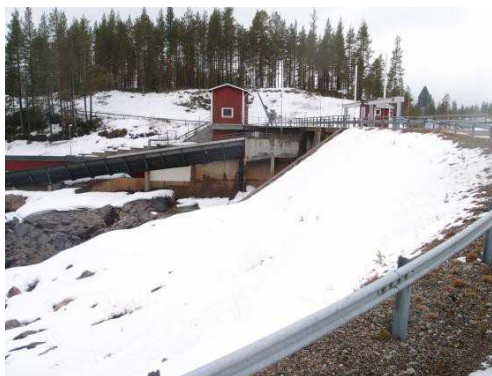
Figur 6. Hednäs kraftverk vy utskovsdamm och intag.
