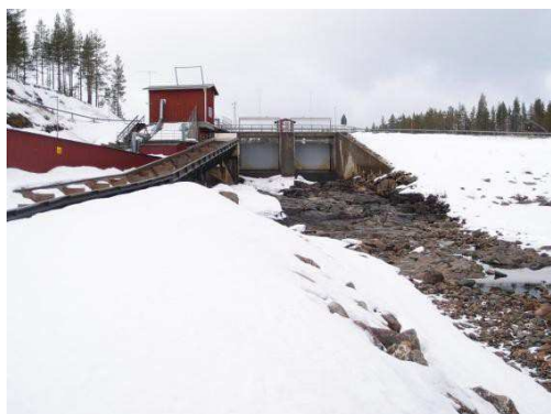
Figur 3. Hednäs kraftverk vy mot utskovsdammen.
