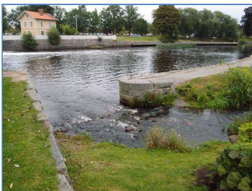
Figur 7. Omlöpet vid Slussdammen i Örebro har en diffus utströmning vilket påverkar anlockning av fisk till omlöpet.
