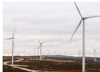
Sedan augusti pågår resningen av torndelarna till de nio turbinerna i den fjärde och sista etappen av Blaiken vindkraftpark.
