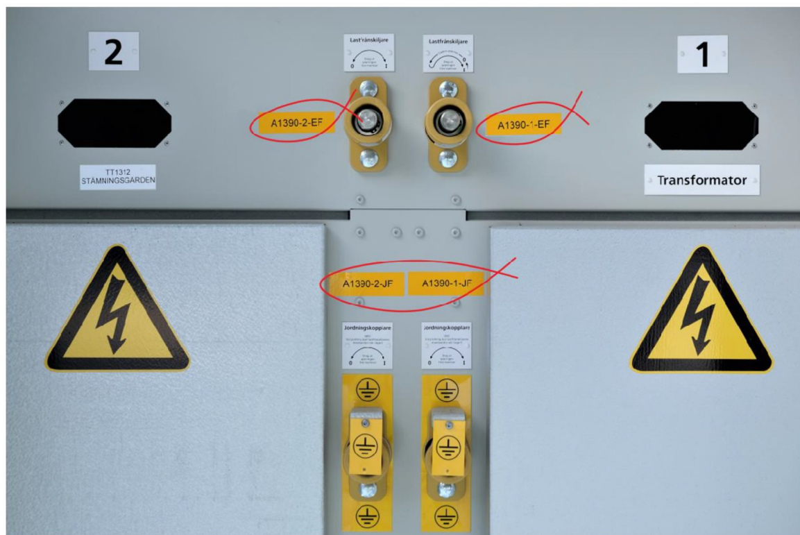
(Holtab, ID-märkning i högspänningsfack)
