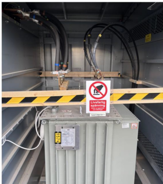
(PART-märkning av kablar och förbudsskylt på regel)
