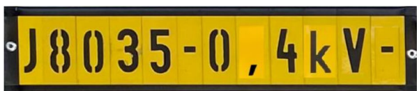
(Lågspännings-ID, 0,4 kV-skena)
