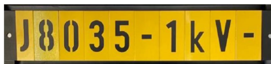
(Lågspännings-ID, 1 kV-skena)
