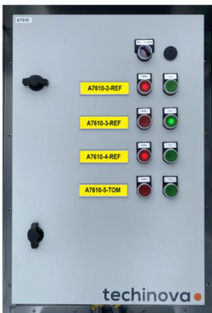
(Technova, Skyltstorlek 100 x 28 mm, textstorlek 10 mm)
