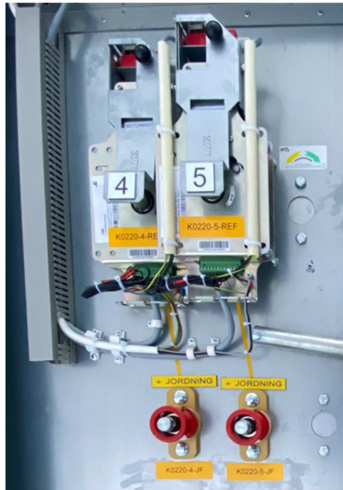
(NAB, manöverfack/motordon fjärrstyrning)
