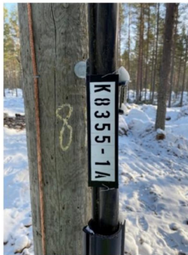
(Kabel går till kopplingsstation, HSP-fack 1A)
